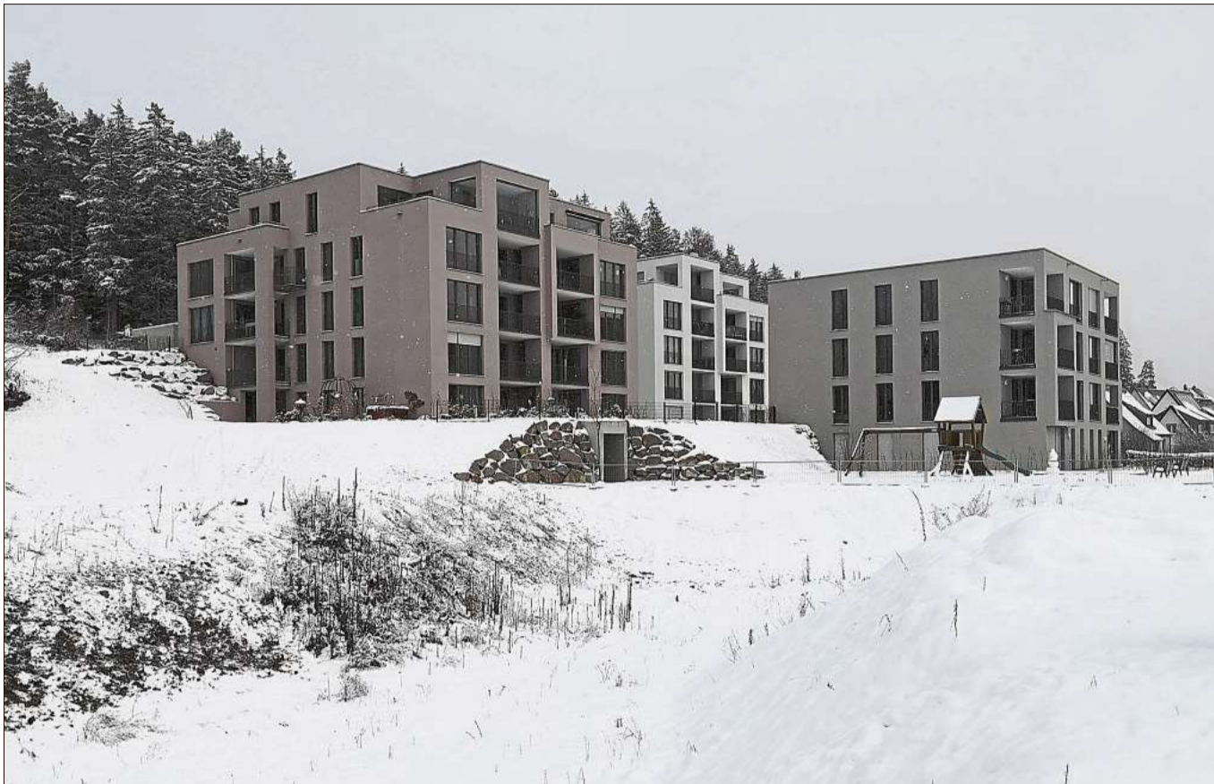
Das Wohnquartier Schönblick soll erweitert werden. Im ersten Bauabschnitt sind bereits drei Wohnblöcke entstanden. Foto: Ginter
